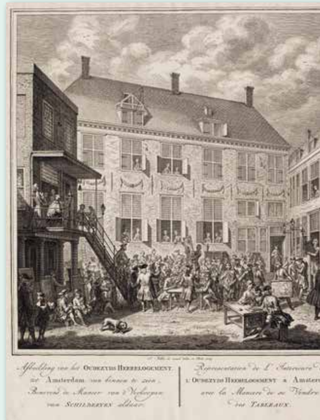
Binnenplaats van het Oudezijds Heerenlogement, 1774.
